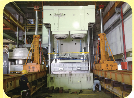
大型油壓機設備吊裝定位
