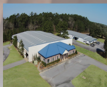
奥林美国托马斯维尔工厂 Oilon Factory in Thomasville, USA
