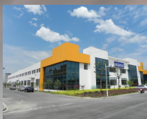
奥林中国无锡工厂 Oilon Factory in Wuxi, China
