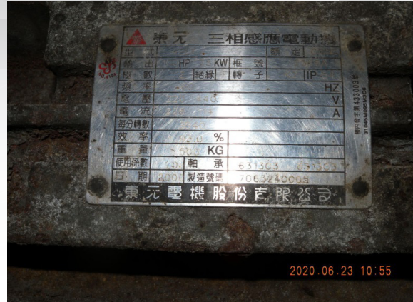
熱媒油循環泵之原設計馬達電源電壓頻率 (220V, 60Hz)
