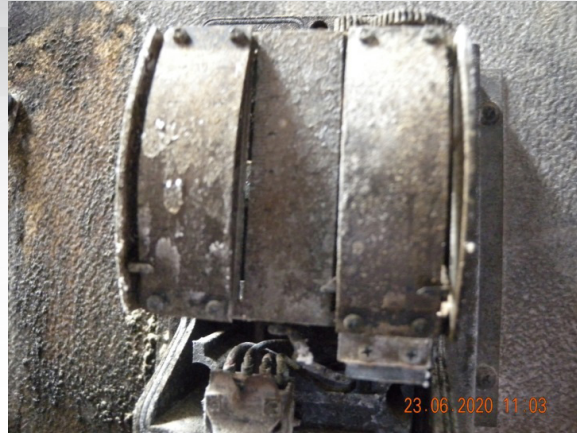
差壓計毀損，其差壓保護之設定值變動為0kg/cm 2 ，無低流量保護。
