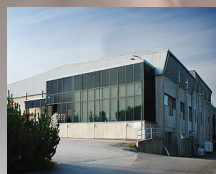
奥林芬兰科科拉工厂 Oilon Factory in Kokkola, Finland
