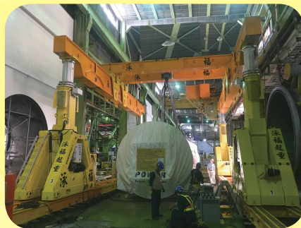
國營事業設備吊裝
